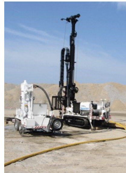
Figure 2 : Foreuse à circulation inverse
